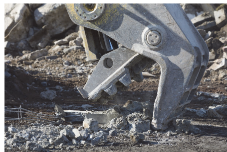
Zerkleinerung von bewehrtem Beton mittels Bagger
